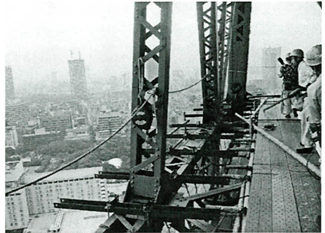
写真一3 足場基部ベース金物
