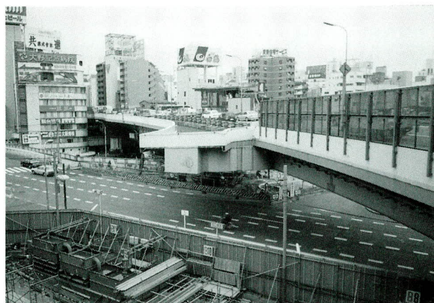
写真-2 既設本線桁の結合仕口
