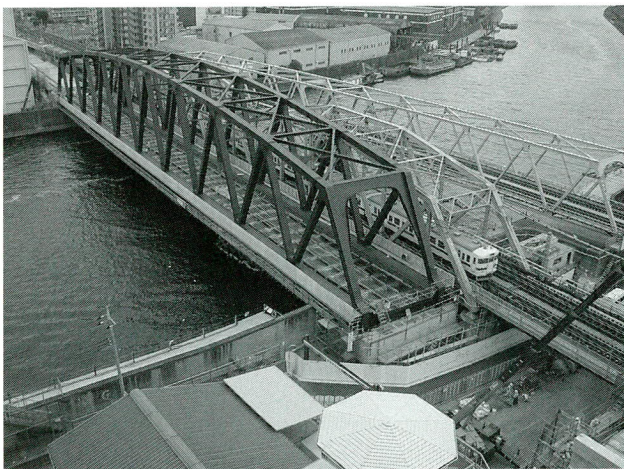
写真-2 架設完了後
