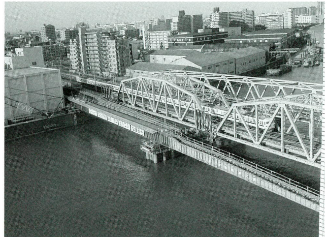
写真-3 工事桁手延べ送り出し架設中
