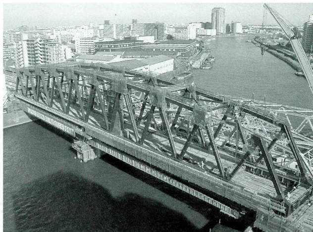
写真-10 大型クレーンにて対岸よりトラス架設中
