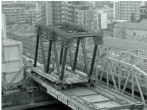
写真-6 トラス2パネル架設完了
