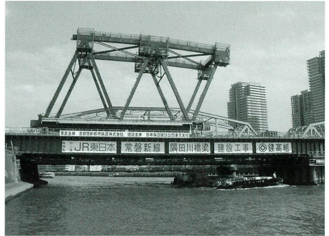
写真-7 トラス縦移動作業中
