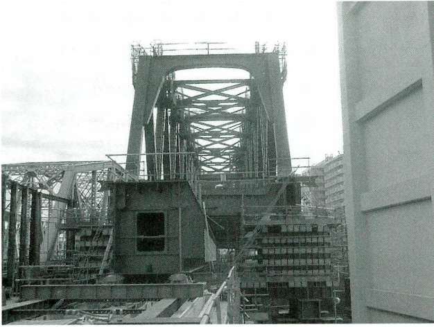
写真-11 工事桁引き戻し作業中
