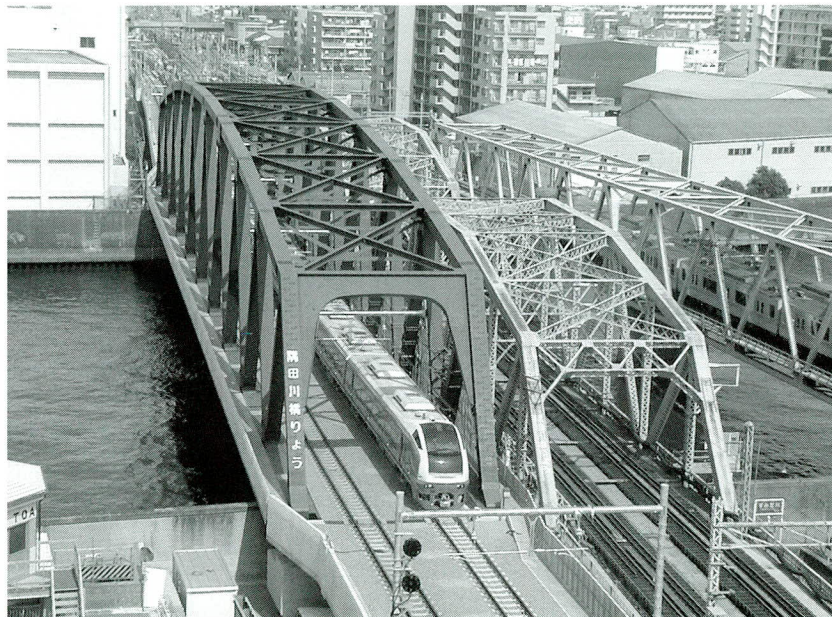
写真-14 工事完了
