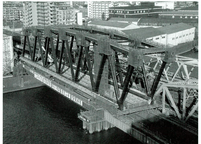
写真-8 トラス6パネル架設完了
