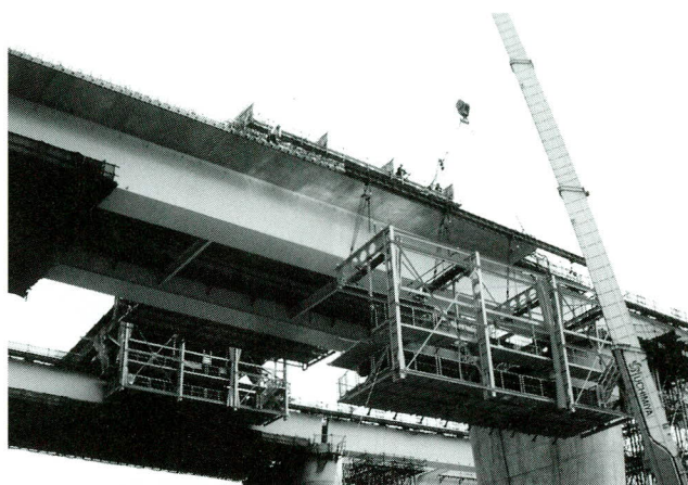
写真-27 移動型枠のブロック組立
