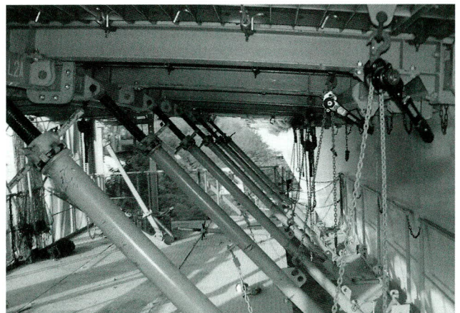
写真-33 セットが完了したアウトサイド型枠
