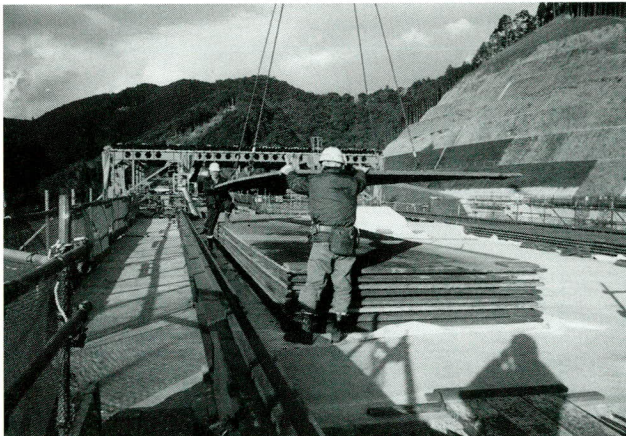
写真—58 カウンターウエイトの設置
