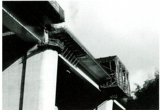
写真-14 アウトサイド型枠と分離した移動足場
