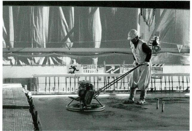
写真-48 トロウエルによる表面仕上げ
