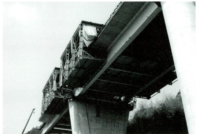
写真-26 中間支点部隣接ブロックの施工
