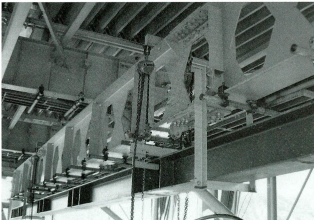
写真-35 吊り上げ、固定された軌条設備
