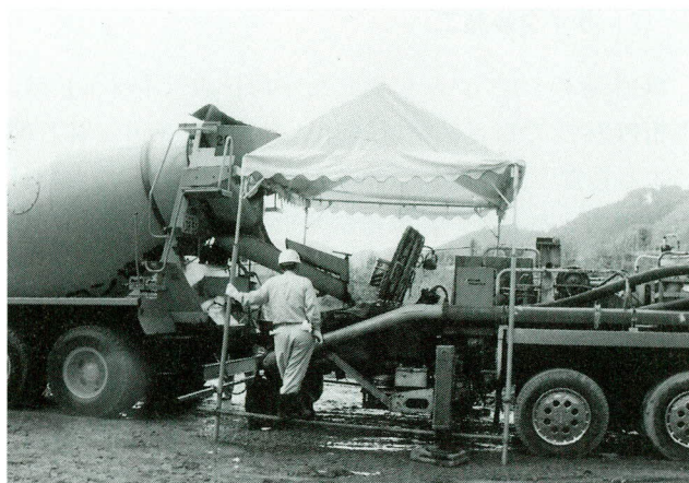
写真-61 テントによるコンクリート養生
