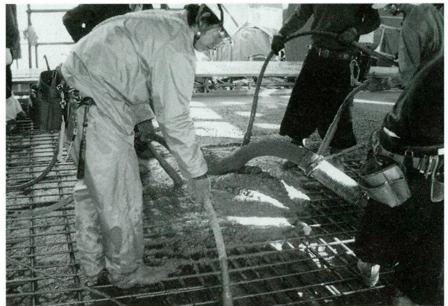
写真-44 コンクリートの打込み
