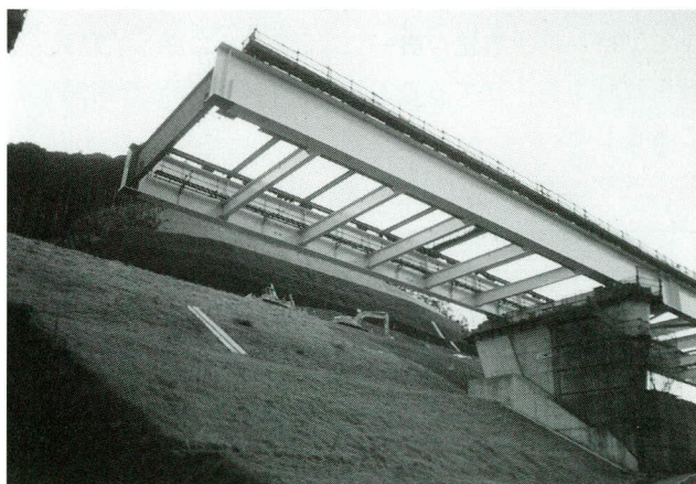
写真-7 鋼桁の送り出し架設
