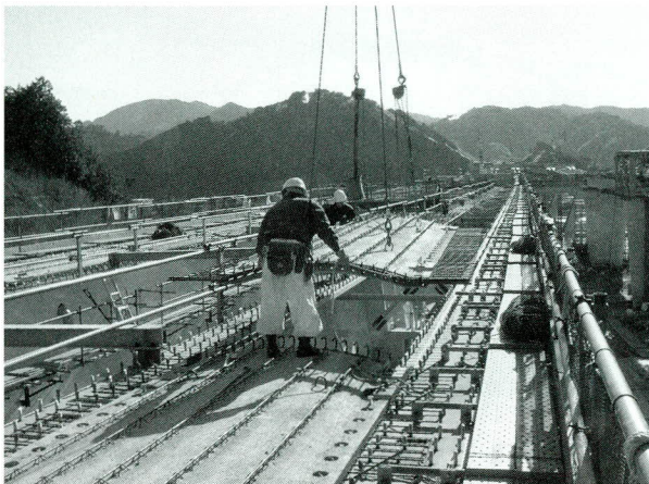
写真-8 PCF版の据え付け
