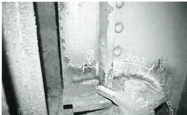
写真-1 鉸桁端支点部
