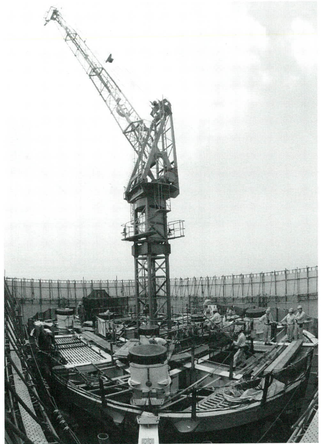
写真-3 建方最上部の状況
