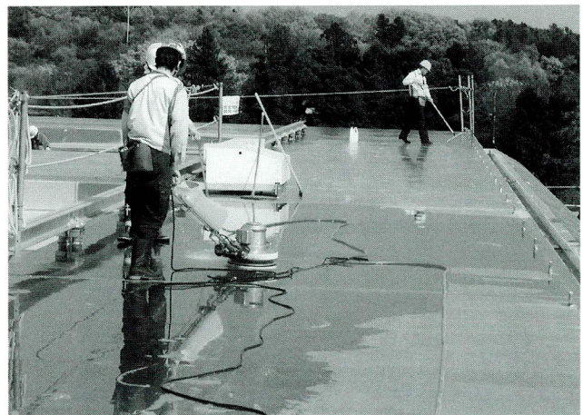
写真-12 水洗い状況
