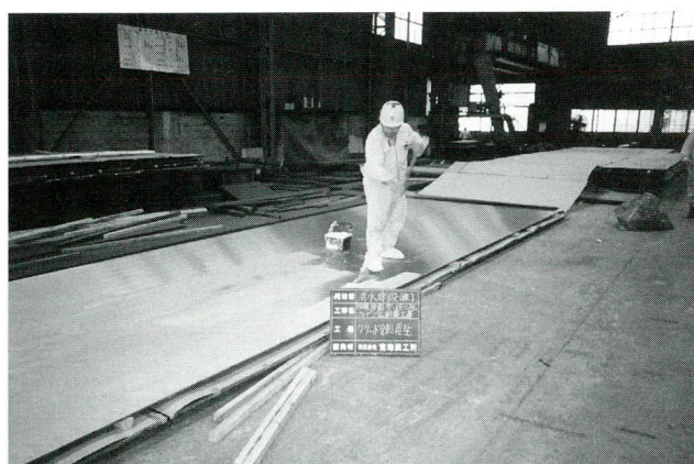
写真一6 表面保護剤の塗布作業
