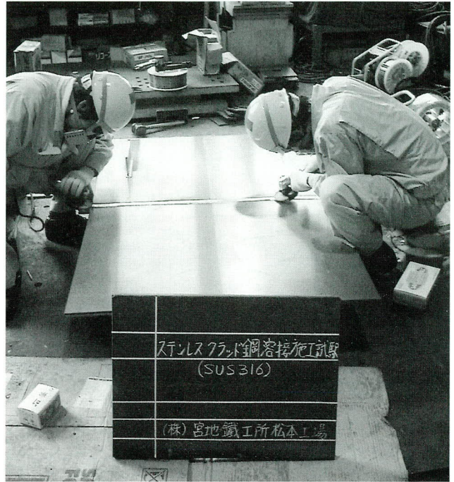
写真-4 突合せ溶接のビード削除
