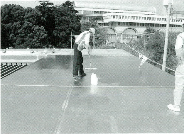
写真-13 ワックス仕上げ状況
