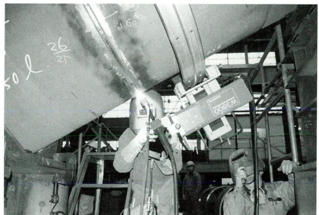
写真-1 SY-ROBO W3800による鋼管全周溶接
