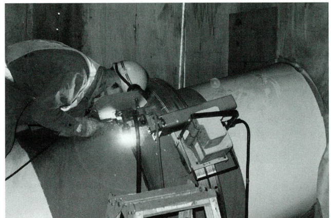
写真-4 鋼管アーチリブの現場溶接状況
