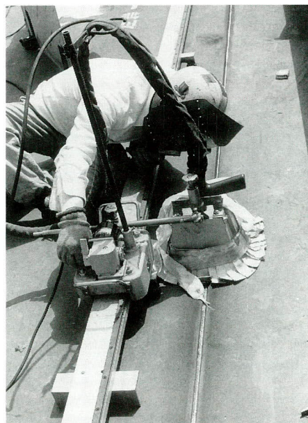
写真-4 S & WCO 2 法施工状況
