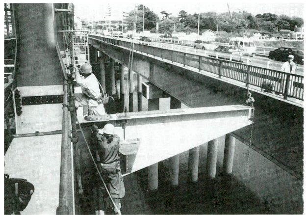
写真-15 歩道部の架設
