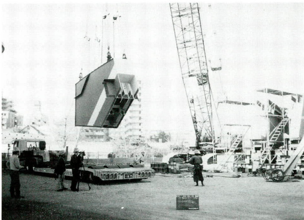
写真-7 アーチリブ地組立状況
