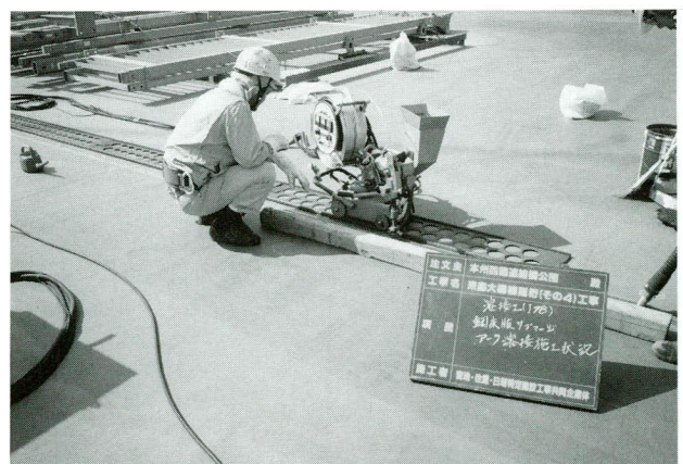
写真-7 デッキプレート溶接状況
