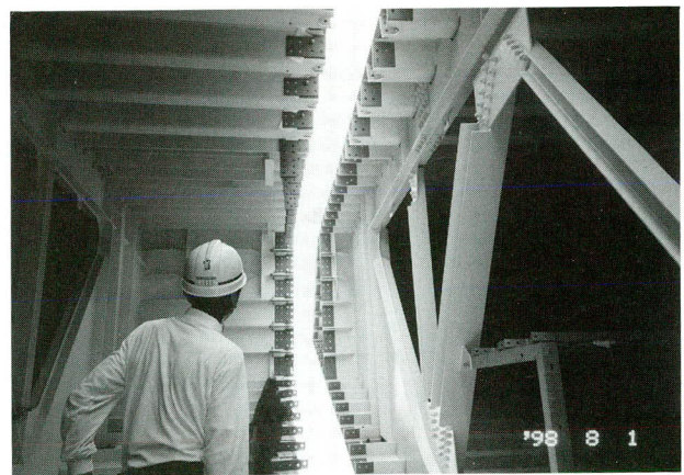
写真-10 吊上げ完了時の既設桁とのクリアランス
