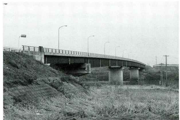
写真-2 協雄大橋
