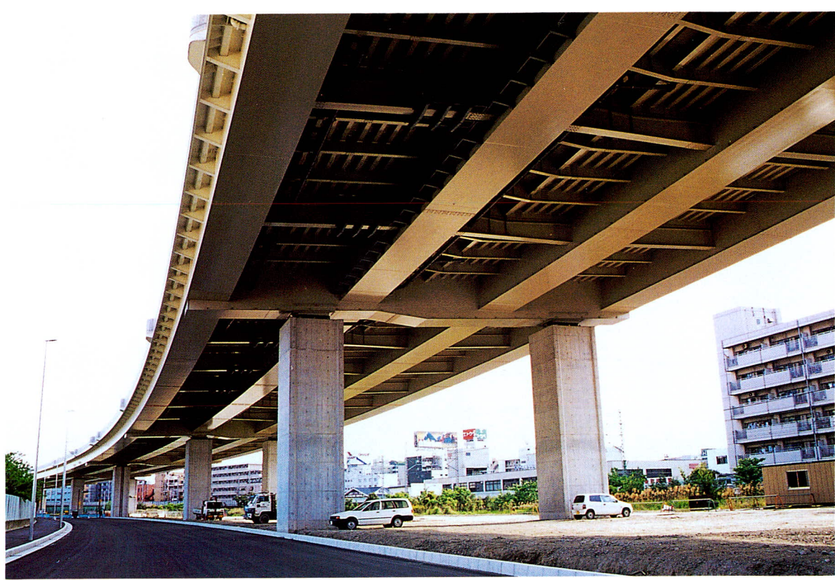
BY524工区(2-2)高架橋
