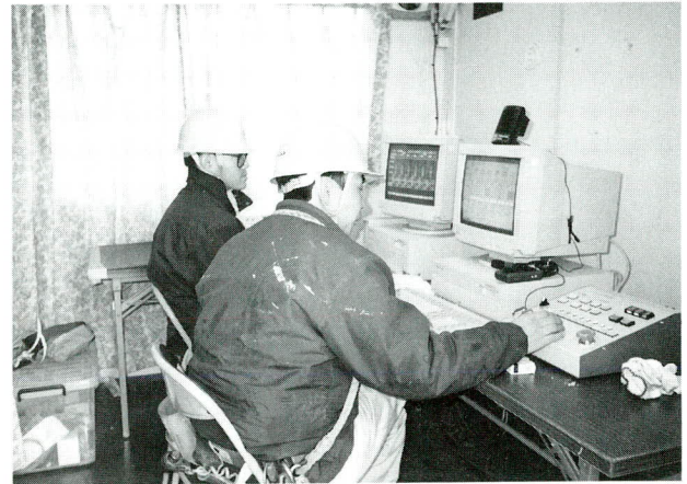
写真-12 ハンガー引き込み作業（制御室）
