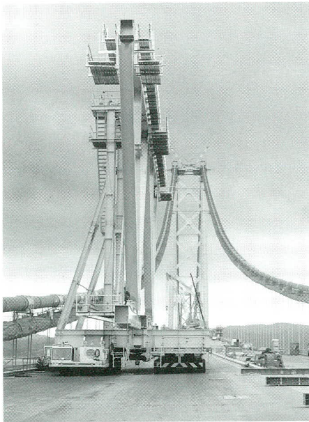
写真-3 自走式運搬台車 (面材運搬)
