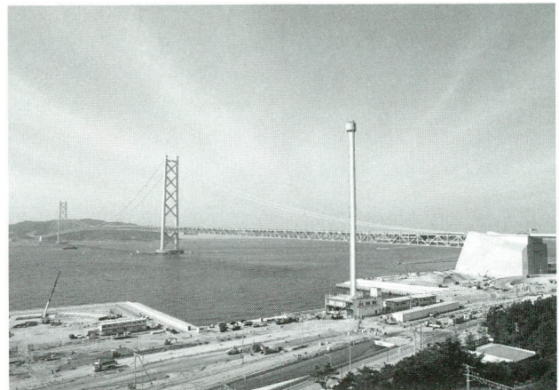
写真-1 工事完了(平成10年3月)
