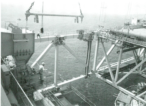
写真-14 塔付部閉合（面材架設状況）
