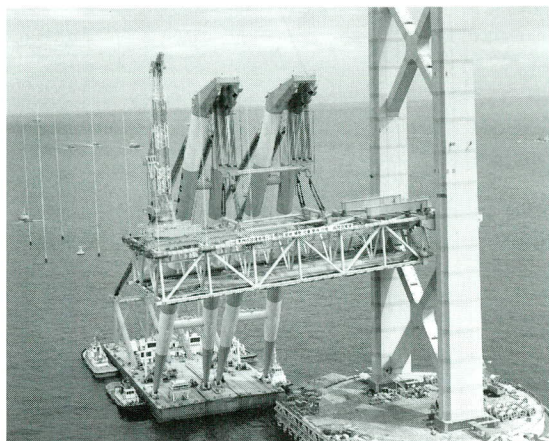
写真-7 塔付部大ブロック架設状況
