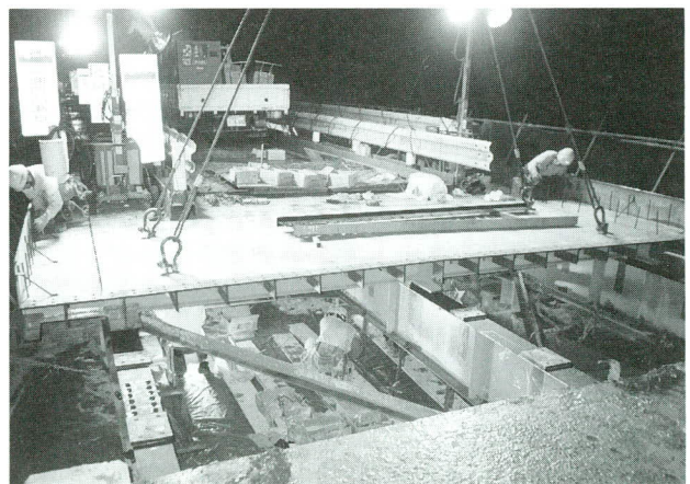
写真-4 鋼床版架設状況
