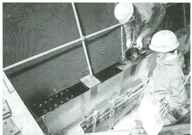
写真-3 既設桁上フランジ永久塗装
