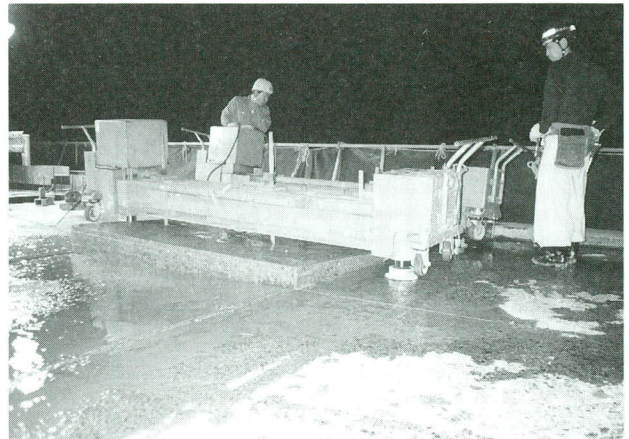
写真-2 ジャッキビームによる床版撤去
