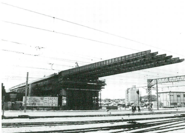
写真-1 連続桁送り出し状況
