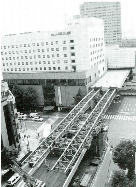
写真-3 単純桁 送り出し状況
