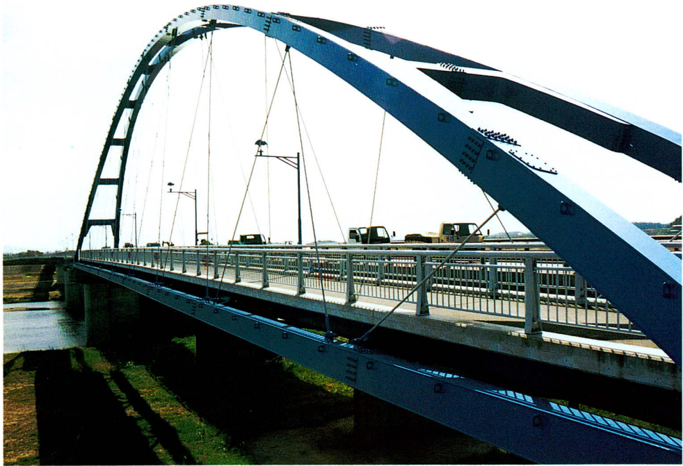
大淀橋側道橋
