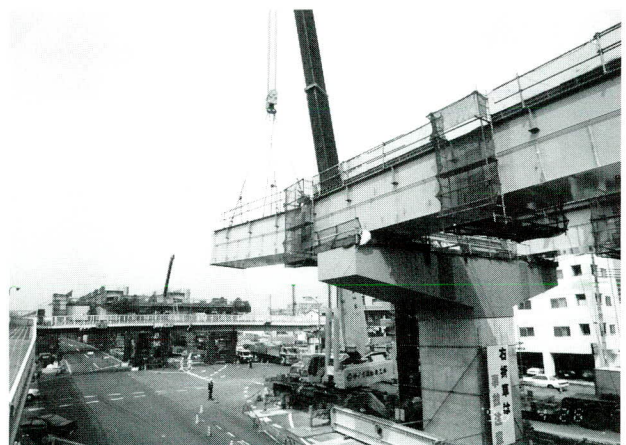
写真-11 3径間連続鋼床版箱桁(再構築)の張出架設
