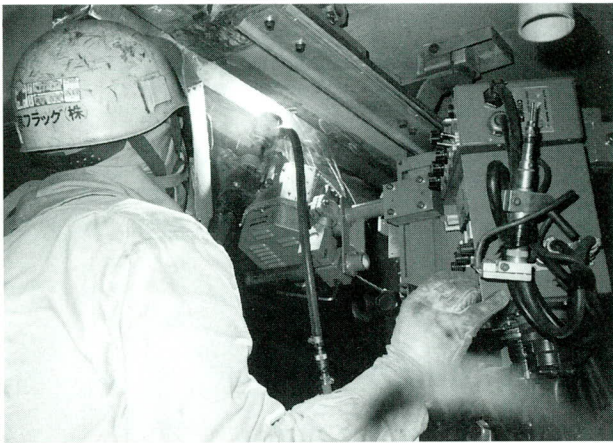
写真-18 梁部下フランジの現場自動溶接
