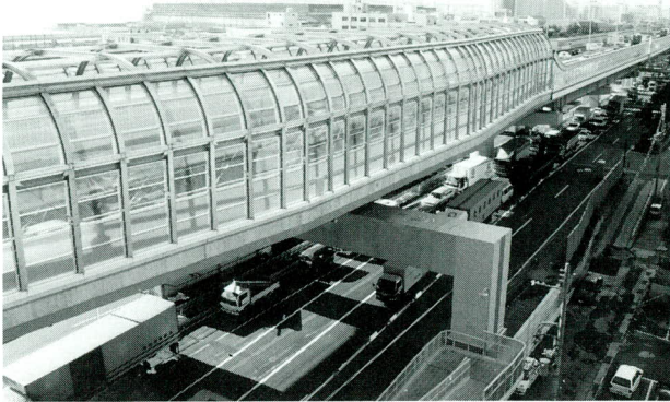
写真-36 山側高遮音壁 神PI50橋脚上
