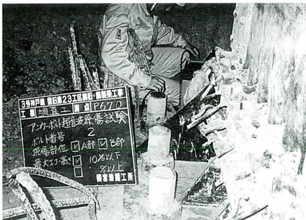
写真-40 超音波探傷検査
