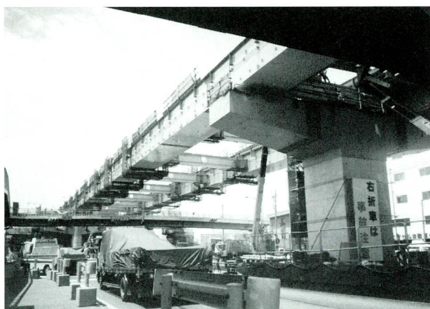
写真-12 3径間連続鋼床版箱桁(再構築)の主桁ブロック閉合
