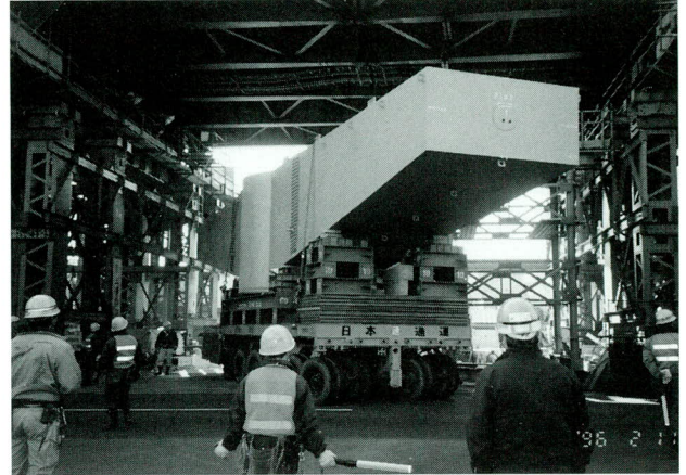
写真-23 トランスポーター輸送
