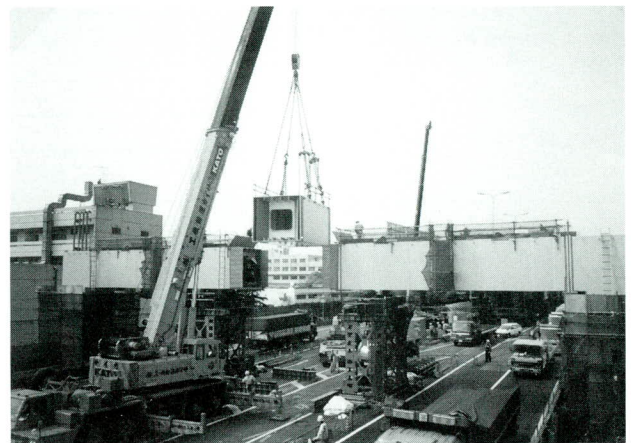
写真-20 梁部最終落し込み架設
