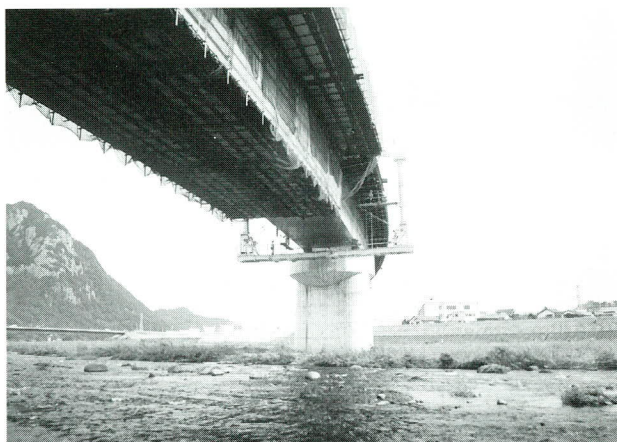
写真-1 吊り足場解体作業中の移動足場全景
