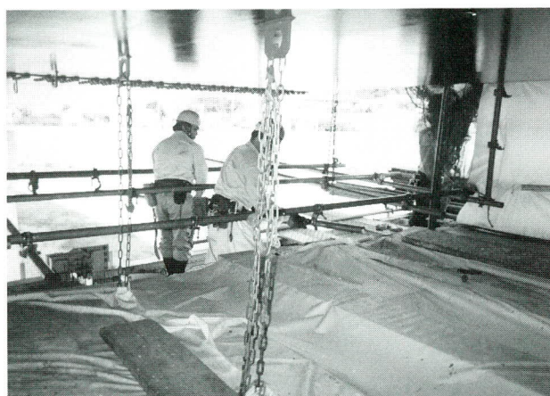
写真-2 移動足場上での吊り足場の解体作業
