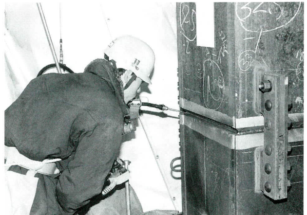
写真-1 ティーチング作業
