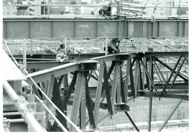
写真-7 直吊り状況
