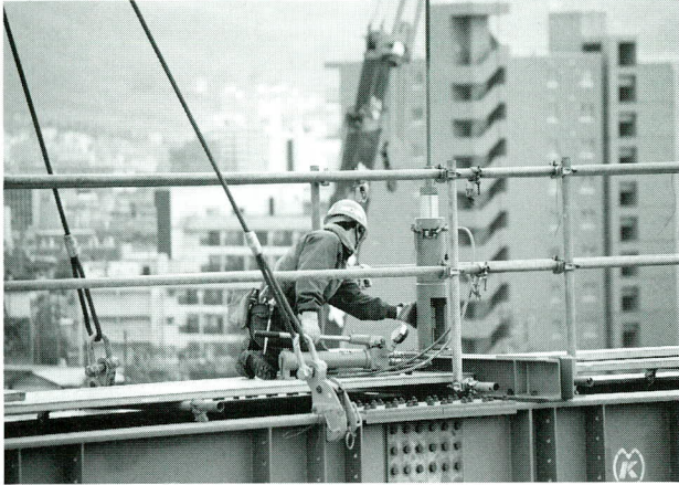
写真-6 吊り点形状調整(50tセンターホールジャッキ使用)
