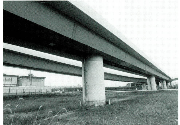
写真-5 施工完了
