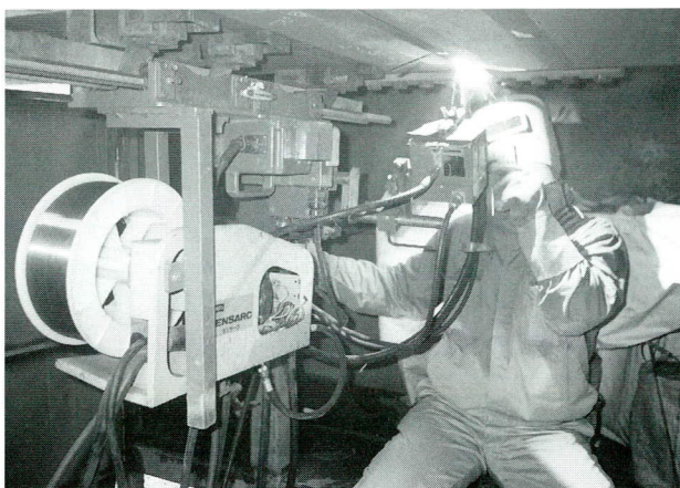
写真-7 下フランジ継手溶接
