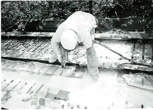
写真-1 ウレタン吹付け施工状況
