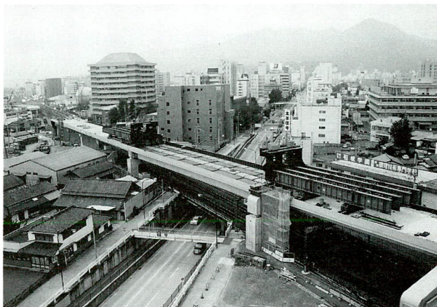
写真-6 G4桁降下完了
