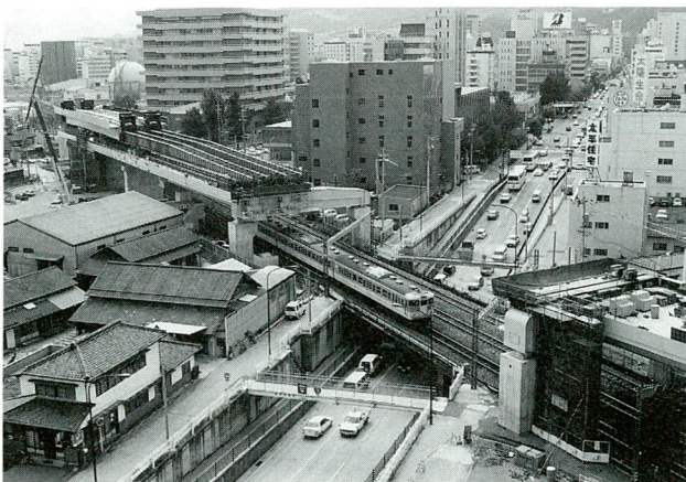
写真-3 G4桁送り出し前
