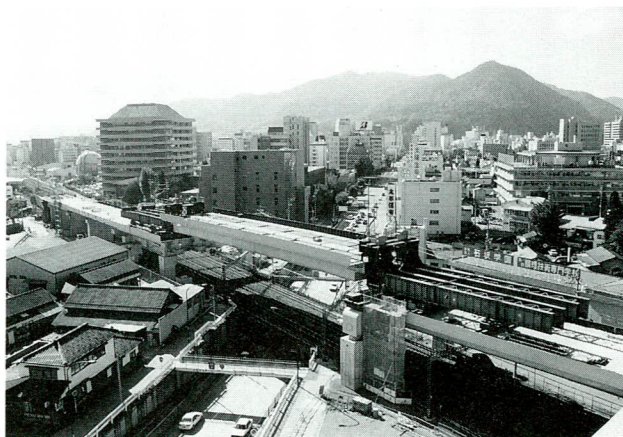
写真-5 G4桁降下前状況
