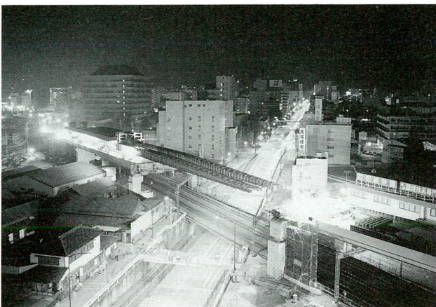
写真-4 G4桁送り出し状況
