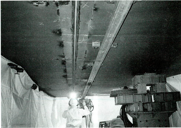
写真-6 横梁下フランジの溶接
