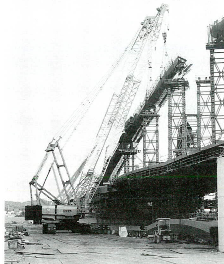
写真-4 アーチ部材の架設
