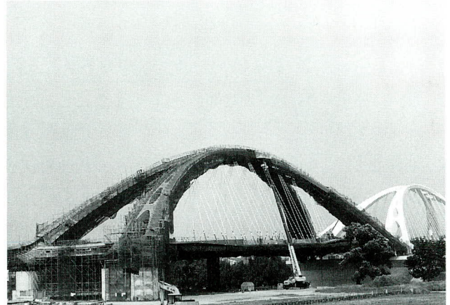
写真-7 豊田橋全景
