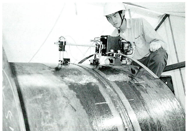
写真一2 全自動UT(ノンガス自動溶接の場合)実験状況
