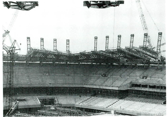
写真一七 ジャッキダウン状況
