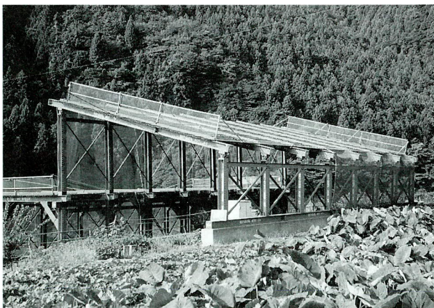
写真-4 国道・鉄道防護工
