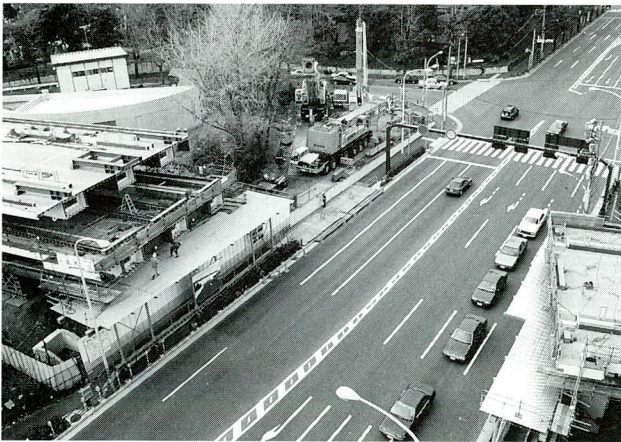
写真一3 交通規制前状況
