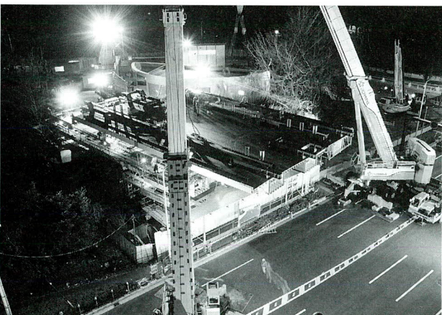
写真一4 架設桁縦取り状況
