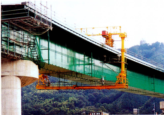
移動足場を用いた吊足場の撤去作業状況
