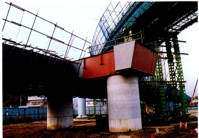
〔仮称〕横浜緑IC橋（日本道路公団）
