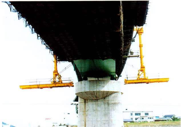
伸縮フレームを拡げ橋脚を通過
