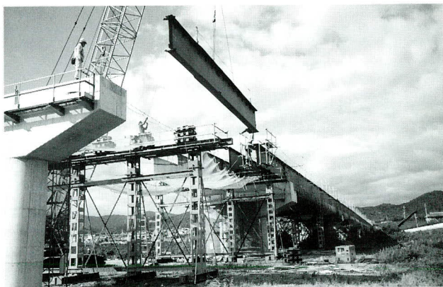
写真-5 主桁の架設
