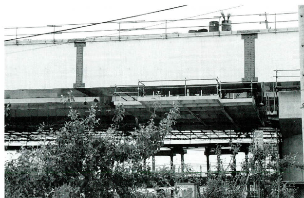
写真-2 移動作業足場による作業
