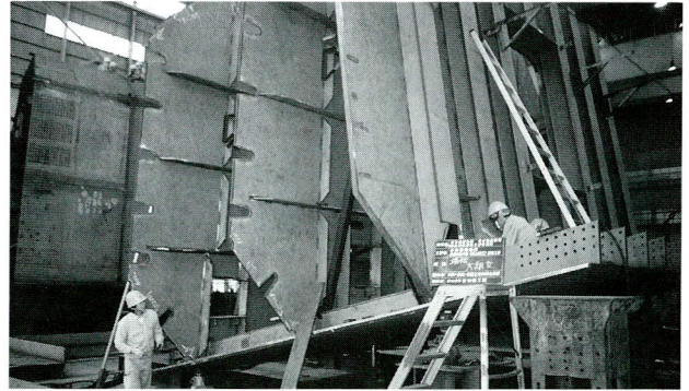
写真-2 ダイヤフラムの建て込み
