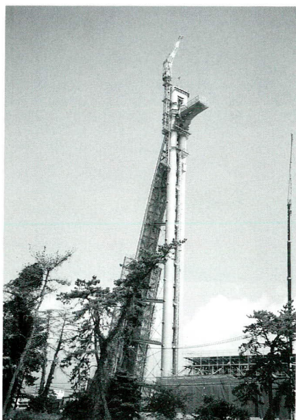
写真-4 高層部建方状況
