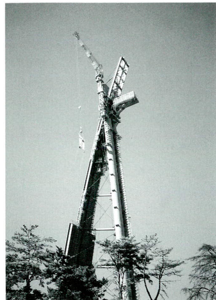
写真-1 建方全景
