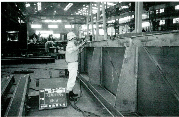
写真-2 上弦リブ・フレーム製作状況
