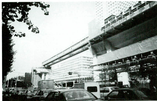
写真-1 呉服橋架設状況
