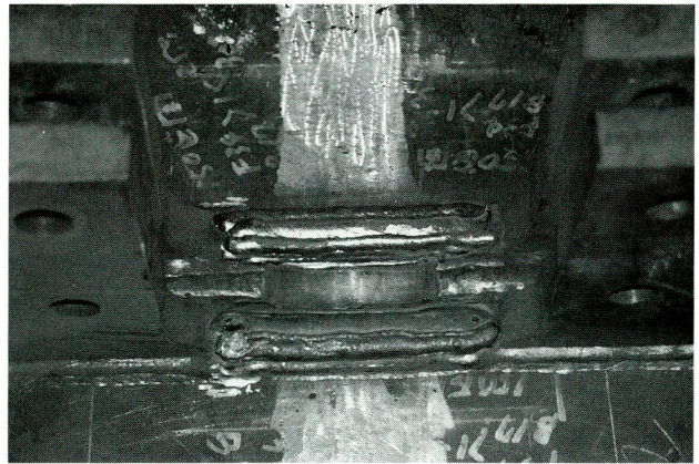
写真-5 縦リブスカーラップ補強溶接
