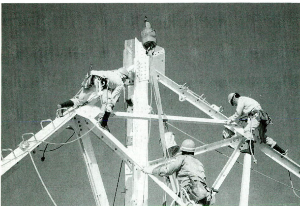
写真-6 キーロック方式安全ロープを使用した作業状況(2)
