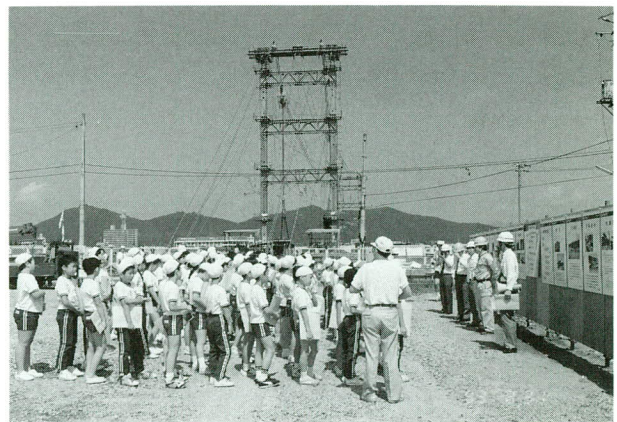
写真-4 第1回工事見学会
