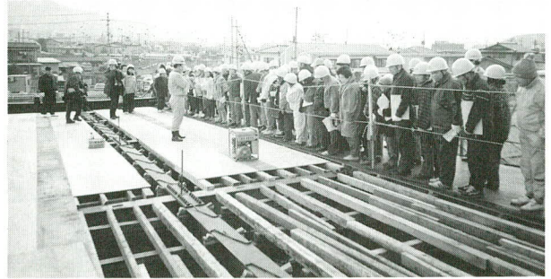
写真-5 第3回工事見学会
