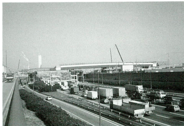
写真-3 湾岸線本線上送り出し完了
