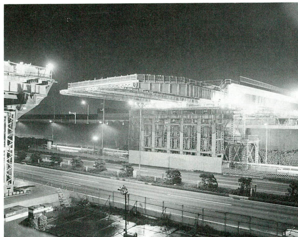
写真-2 湾岸線本線上送り出し状況
