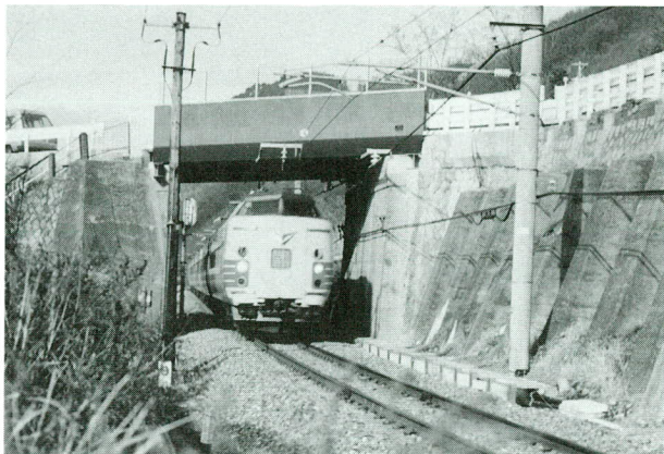
写真-5 工事完了
