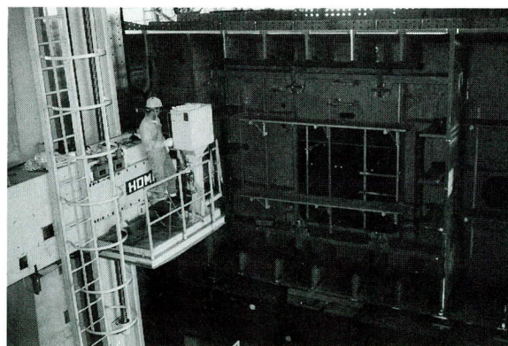
写真-1 塔柱の端面切削
