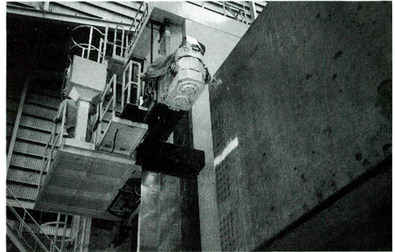
写真-3 添接部の孔明け加工
