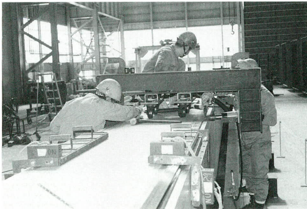
写真-3 はめ込みフランジのはめ込みと密着組立状況
