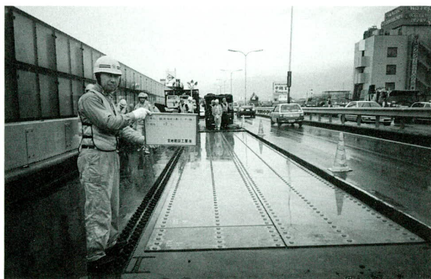
写真-3 デッキプレート補強構造
