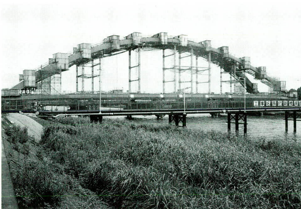
写真-3 現場溶接の風防施設の状況
