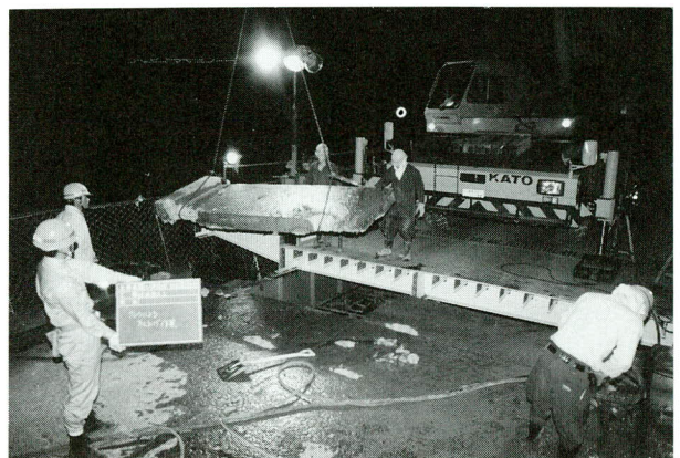
写真-1 クレーンによる取上げ作業
