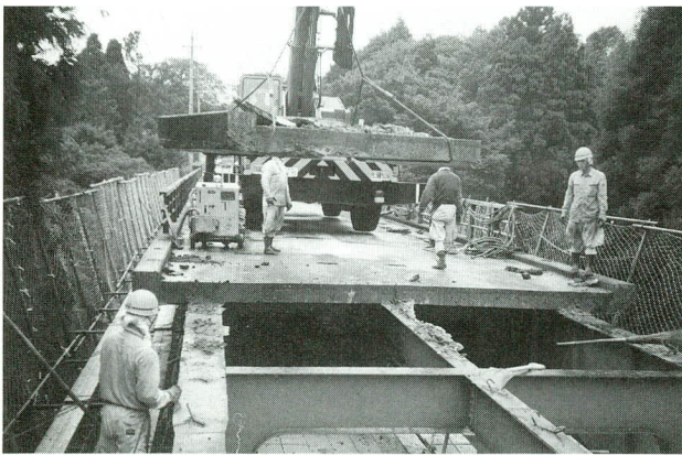
写真-2 床版撤去作業
