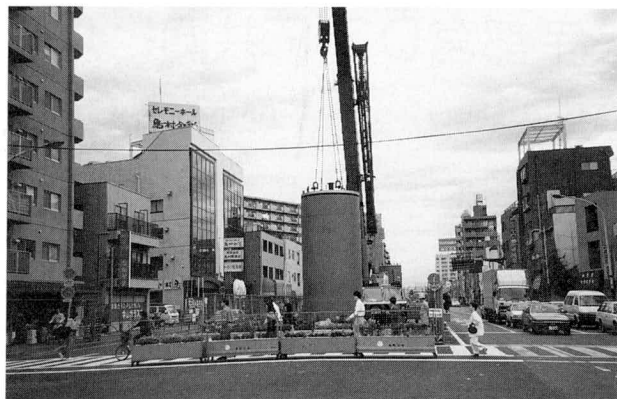
写真-2 脚柱の架設(昼間施工、4車線確保)
