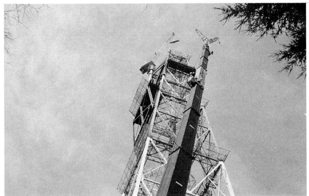
写真-6 鉄塔解体状況
