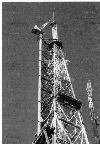
写真-3 ジブクレーン据付状況
