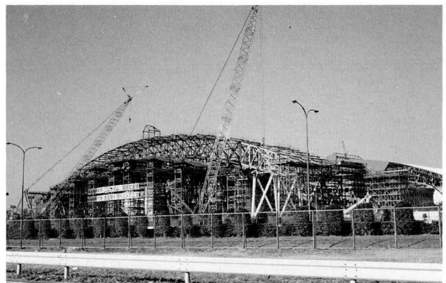
写真-5 トラス架設全景
