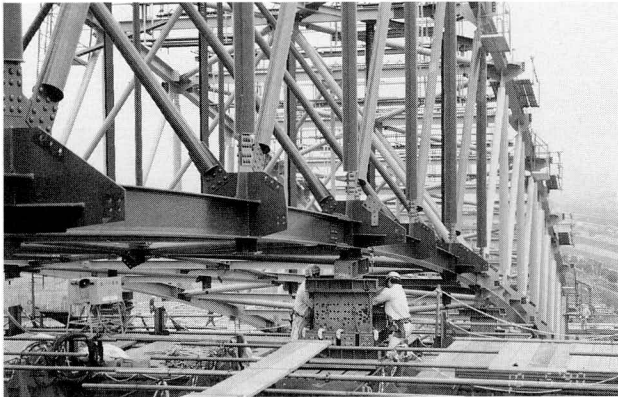
写真-6 ジャッキダウン状況
